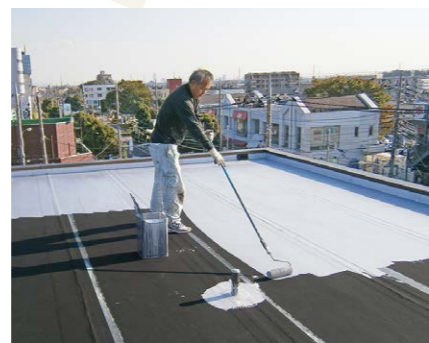
遮熱塗料を下塗りして建物への蓄熱を防ぐ方法も
