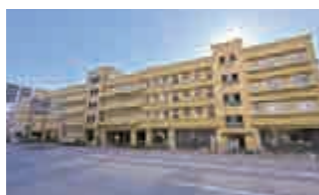
築90年のレトロモダンな建物「清洲寮」。教室は4階から2階に移転したばかり
